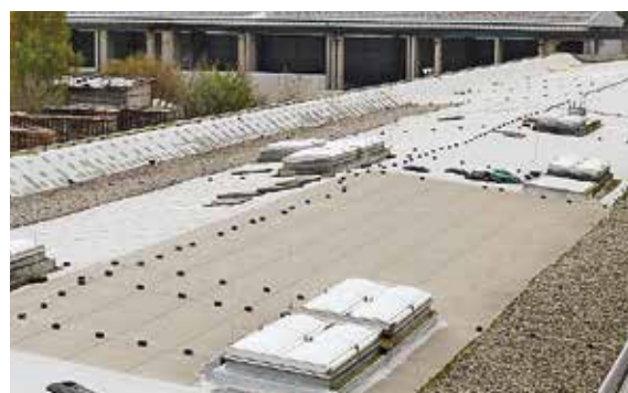
Rauch- und Wärmeabzugsgeräte im Industriebau
